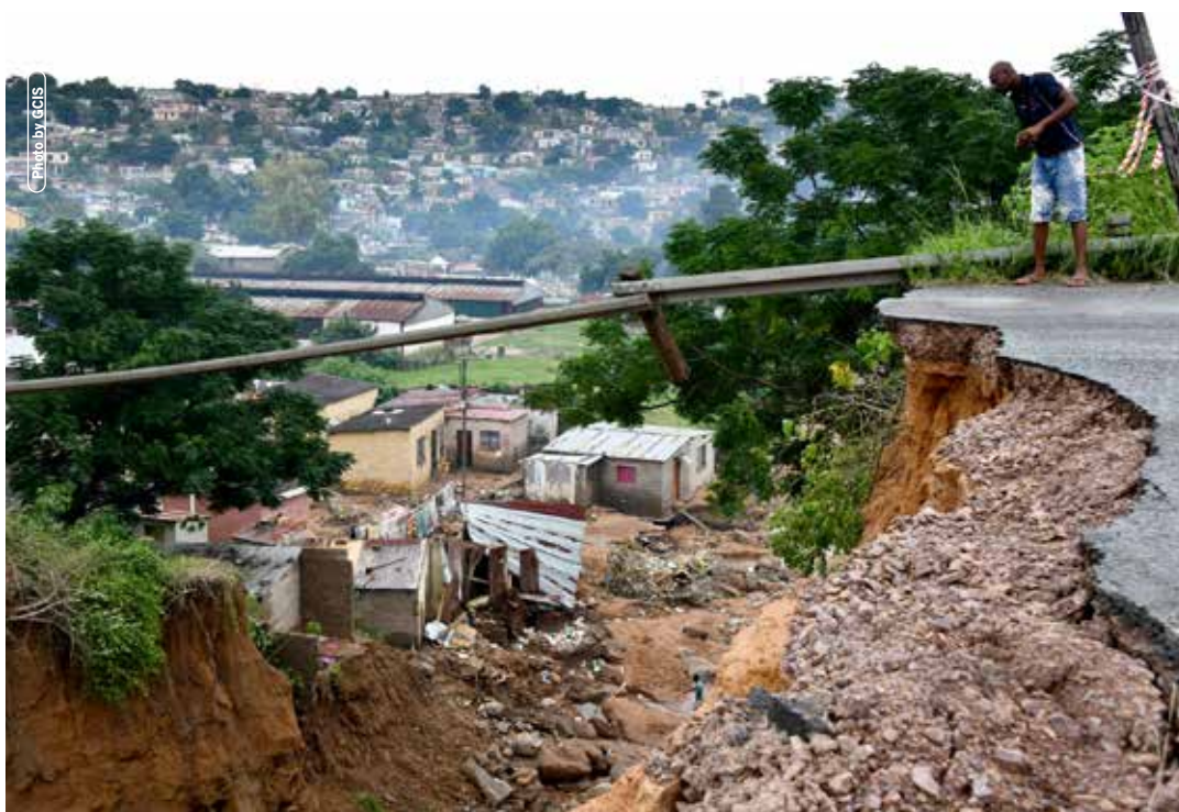
Die reën het erge skade aan huise, ondernemings, paaie en brûe, asook water- en elektrisiteitsinfrastruktuur, veroorsaak.
