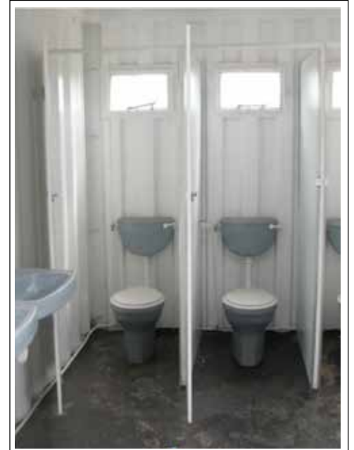
Luphiko Lwemanti Nekutfutwa Kwendle laMasipala wase-eThekweni lisebentisa emakhontena kubukana naletinselele tekutfutwa kwendle nekungcola emikhukhwini kulesifundza.
